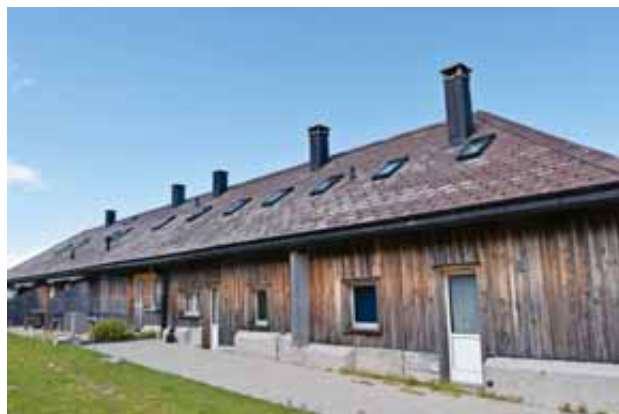
Scheren Obersäss «abgewetterte Dacheindeckung»
