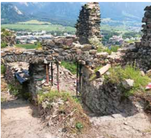
Freigelegte Treppe und Rundbogen Palas Freudenberg
