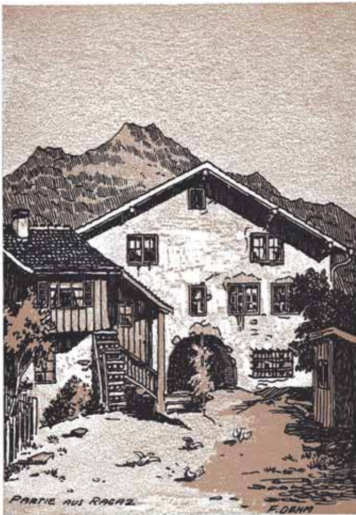
Das alte Zollhaus in Bad Ragaz, erstellt im Jahre 1595, abgerissen 1971
