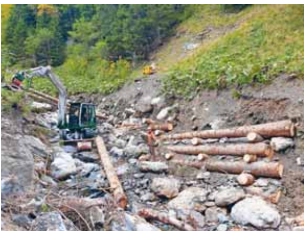
Holzkastenverbauung Zugang Brändlisberg
