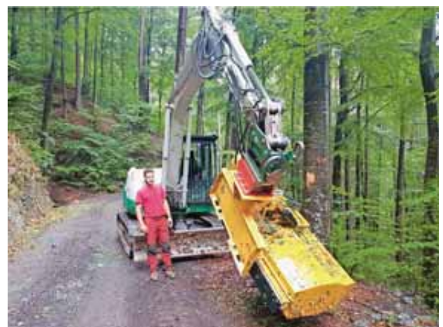
Strassenpflege Zweckverband Tamina Forst
