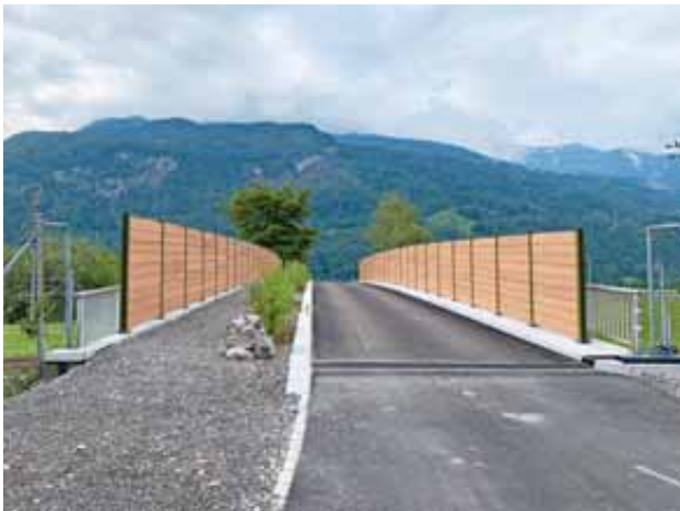
Überführung Freihof mit Wildtierübergang
