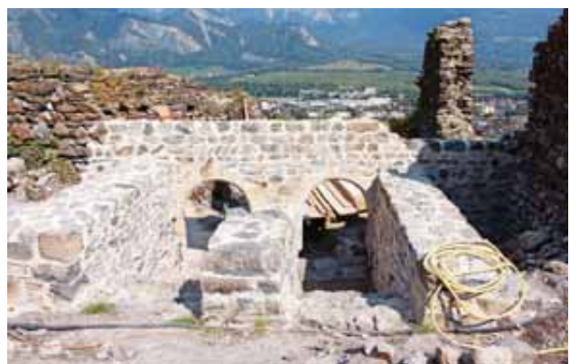
Sanierter Torbogen im Palas
