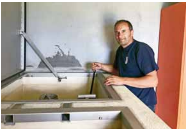
Remo Widrig bei der Arbeit im Reservoir Wissi Stei
