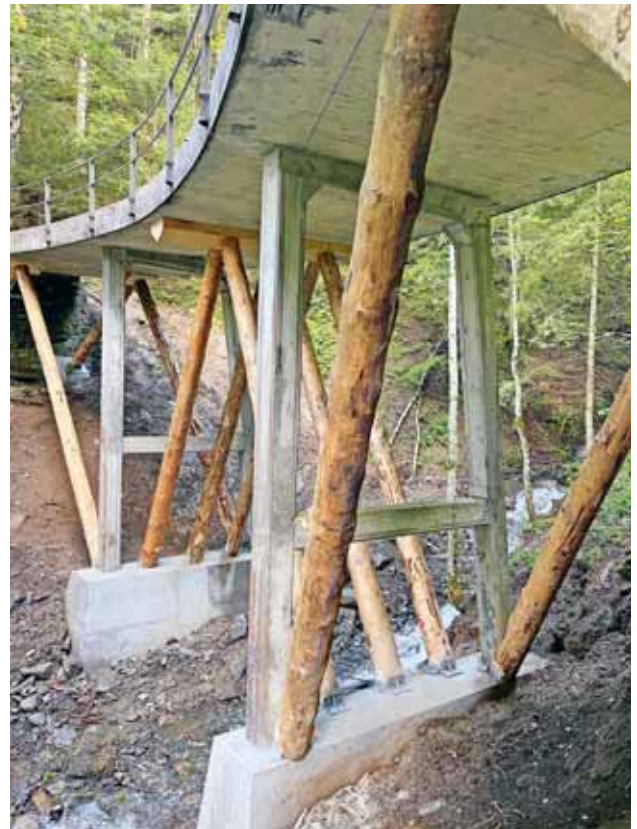
Holzstützen und neue Fundamente Haldenbrücke
