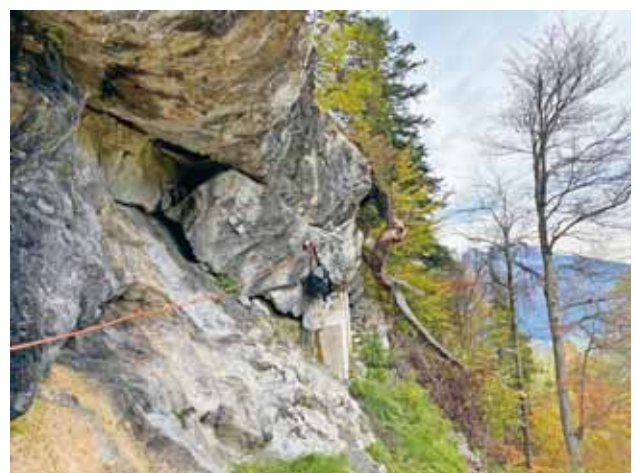
Felssicherung mittels Betonsockel
