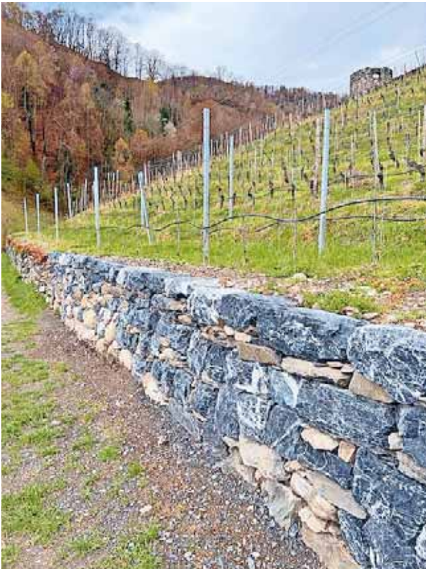
Sanierte Trockensteinmauer Rebberg Freudenberg
