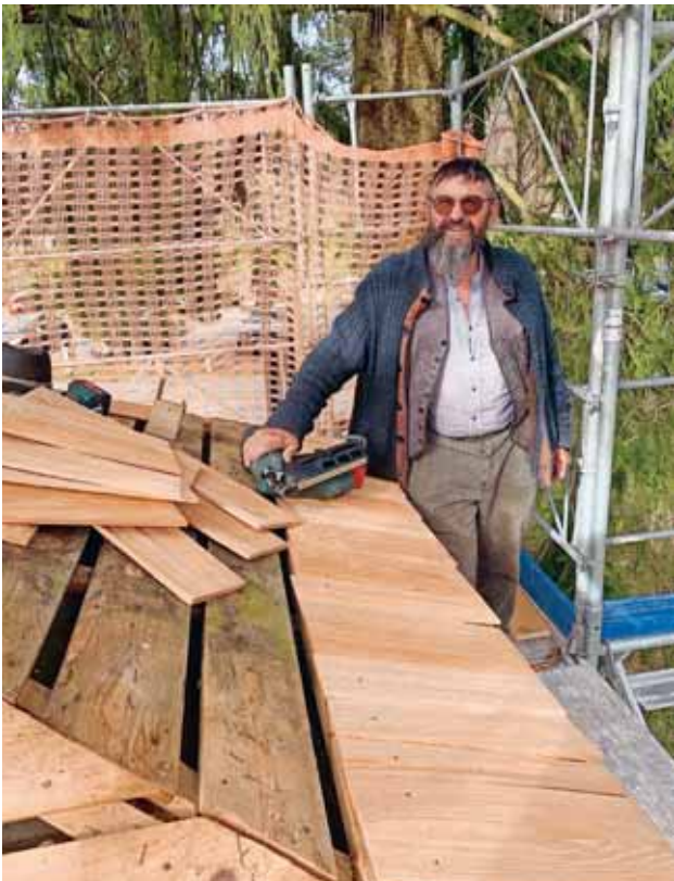
Neues Schindeldach in Arbeit
