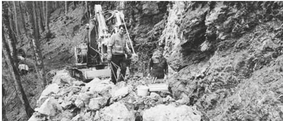
Felsabtrag Alpweg Zaschga , Ortsgemeinde Bad Ragaz (Josias Bantli und Lorenz Hobi)
