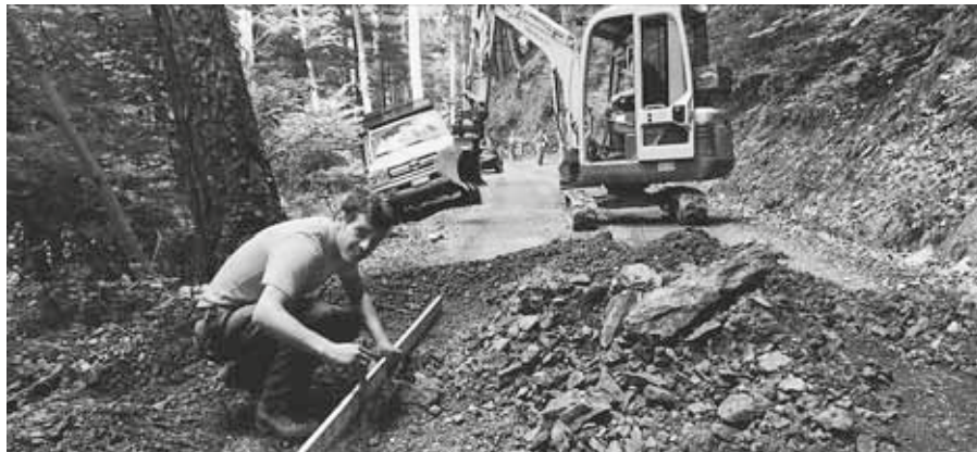
Strassenunterhalt Matells, Ortsgemeinde Bad Ragaz (Manuel Schneider und Adrian Würmli)
