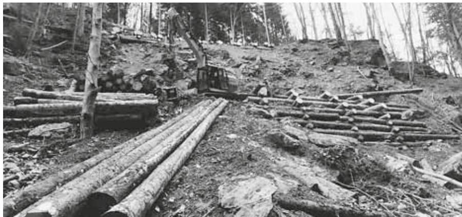
Hangverbauung Badtobel, Strassenkreisinspektorat
