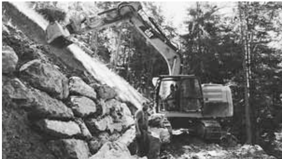
Erstellung Blocksteinmauer Valur, Hochbauamt (Adrian Würmli und Lorenz Hobi)
