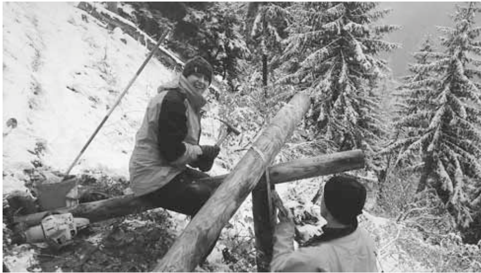
Erstellung Lawinenverbauungen Guettolen, Pfäfers (Bergwaldprojekt)
