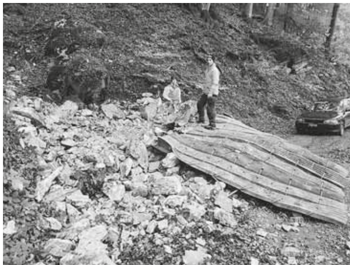
Sprengarbeiten Alpstrasse Matells (Unwetterschäden), Bad Ragaz
