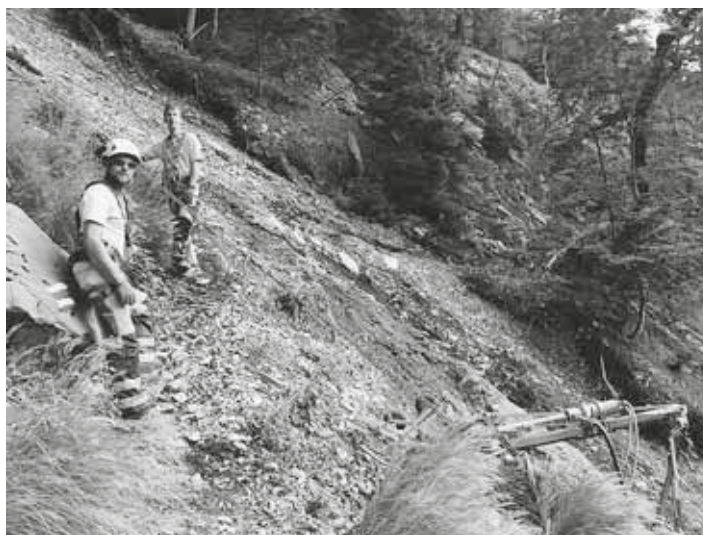
Sanierung Wanderweg Vättnerberg
