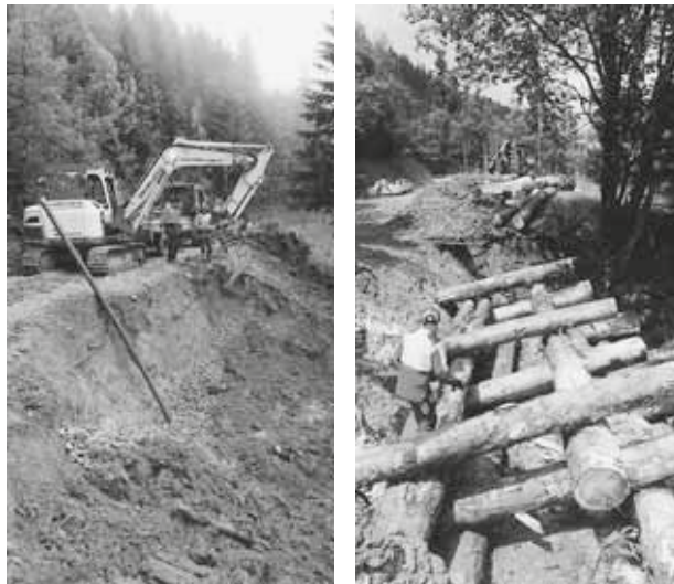
Holzkastenverbauung Fürgglistrasse (Behebung Unwetterschäden)
