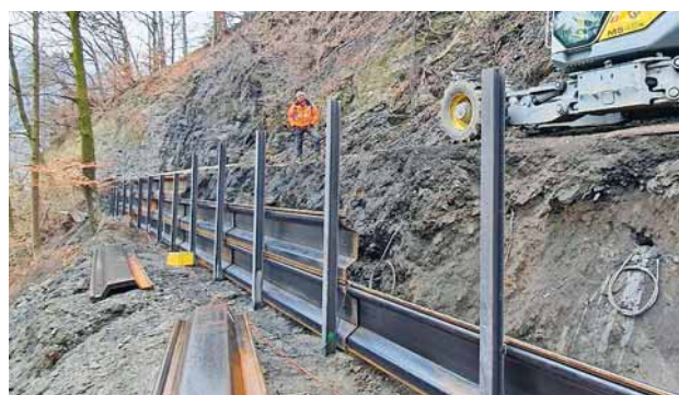
Montage Stahlwand
