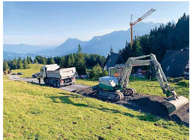
Einbau der Verschleisssschicht
