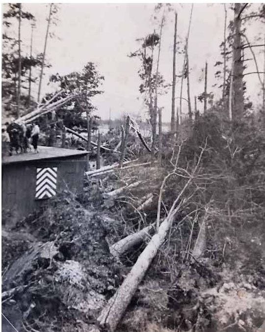
Schadensausmass bei der Pfadihütte
