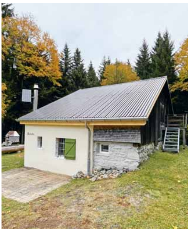
Saniertes Dach Schalfa Hütte
