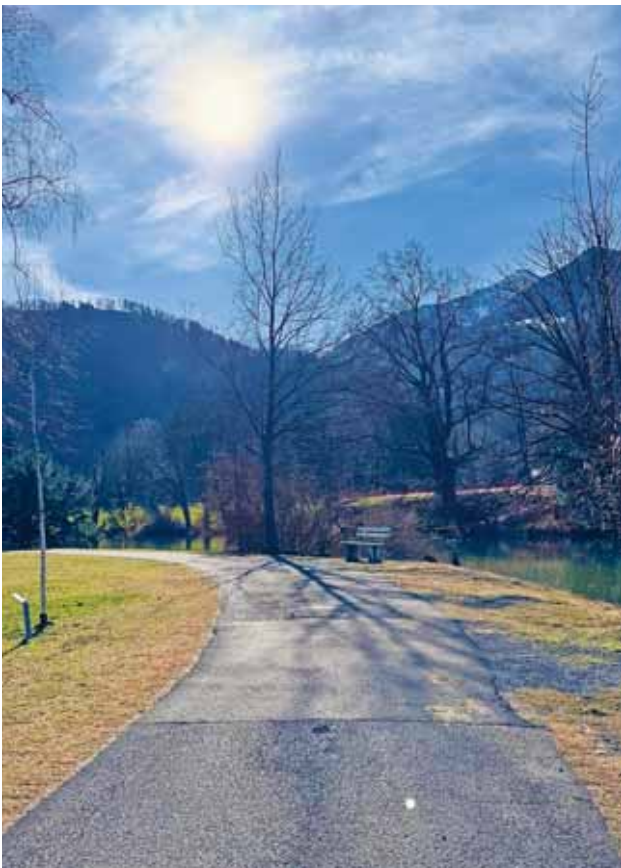
Belagsflicke Biberschäden Giessenseeweg
