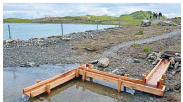
Zulauf Flachwasserbereich Twärchammsee
